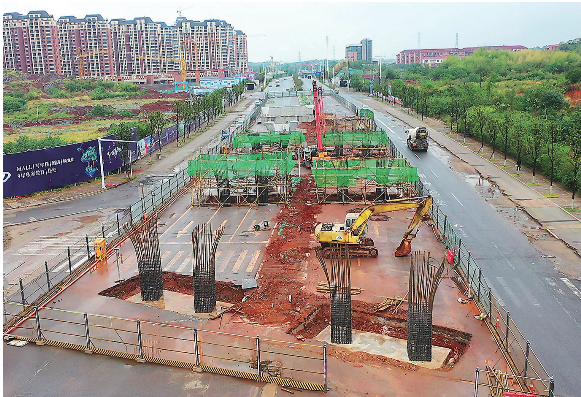
云龙大道跨线桥桩基基础施工完成。 株洲日报记者 谭清云 通讯员 刘喻滋 摄
