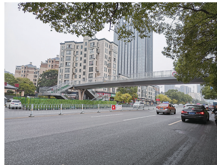
▲陡坡岭小学附近的人行天桥已经基本完工 记者 姚时美 摄
