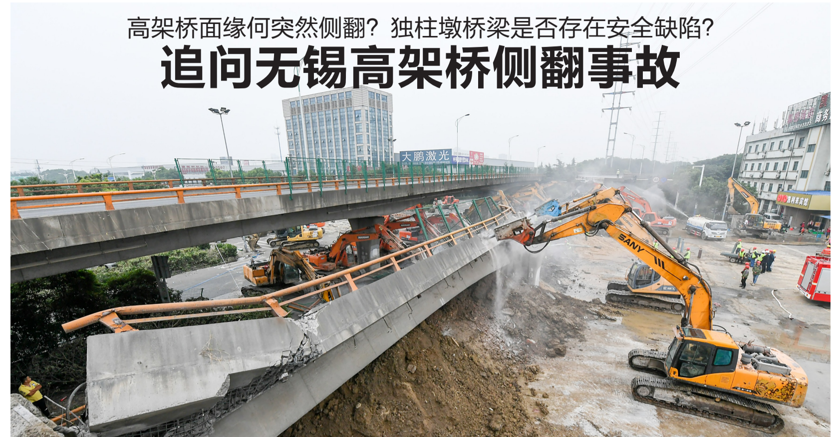
▲10月11日,在江苏无锡高架桥侧翻事故现场,施工机械在破折侧翻高架桥段
