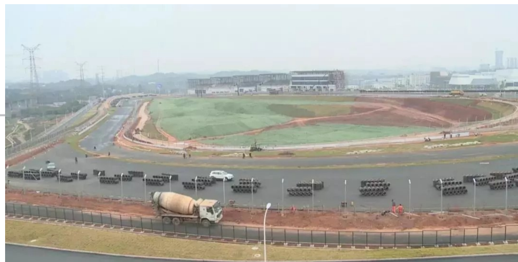
▲建设中的株洲国际赛车场 通讯员供图
