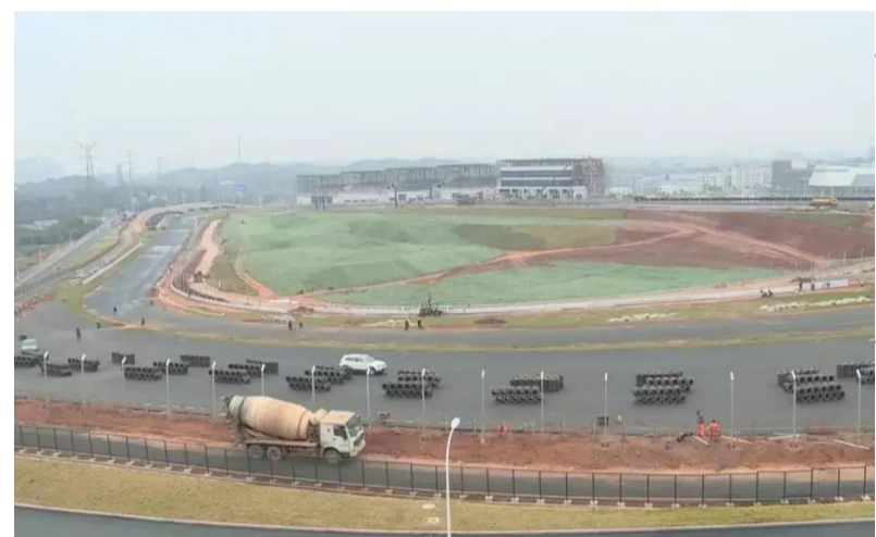
▲建设中的株洲国际赛车场 通讯员供图
