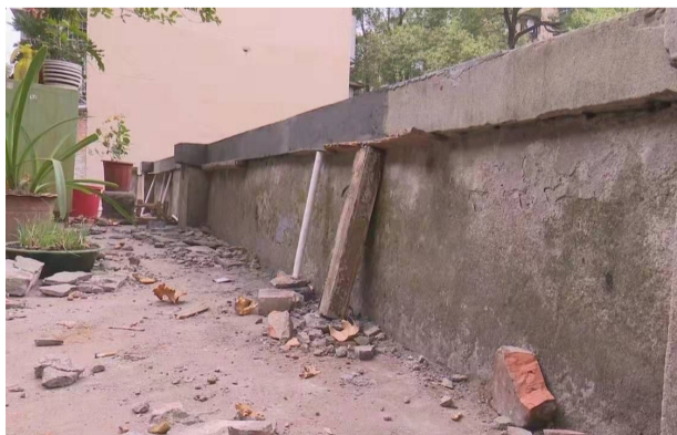
▲茨中村,快要倒的围墙已被修补 记者 陈驰 摄
