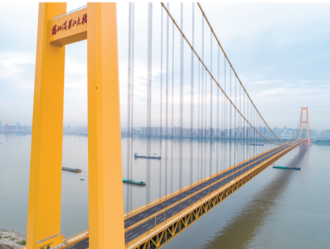
10月8日,长江上首座双层公路大桥——武汉杨泗港长江大桥正式投入使用。杨泗港长江大桥全长4.13公里,主跨1700米,一跨过长江。大桥上层为城市快速路,双向6车道,设计行车时速80公里;下层为城市主干道,双向6车道,设计行车时速60公里。图为武汉杨泗港长江大桥(9月25日无人机拍摄)。
