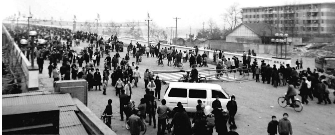
▲1988年,株洲大桥开通,许多市民骑着自行车来到现场 受访者供图
