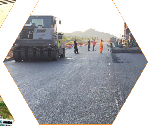
正在进行沥青路面施工的余湾路
