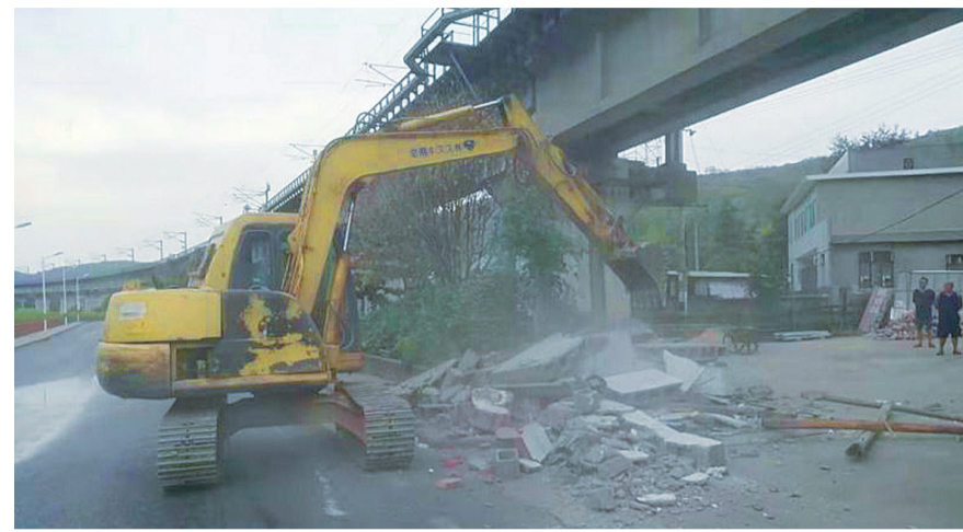
▲拆除现场 通讯员供图
