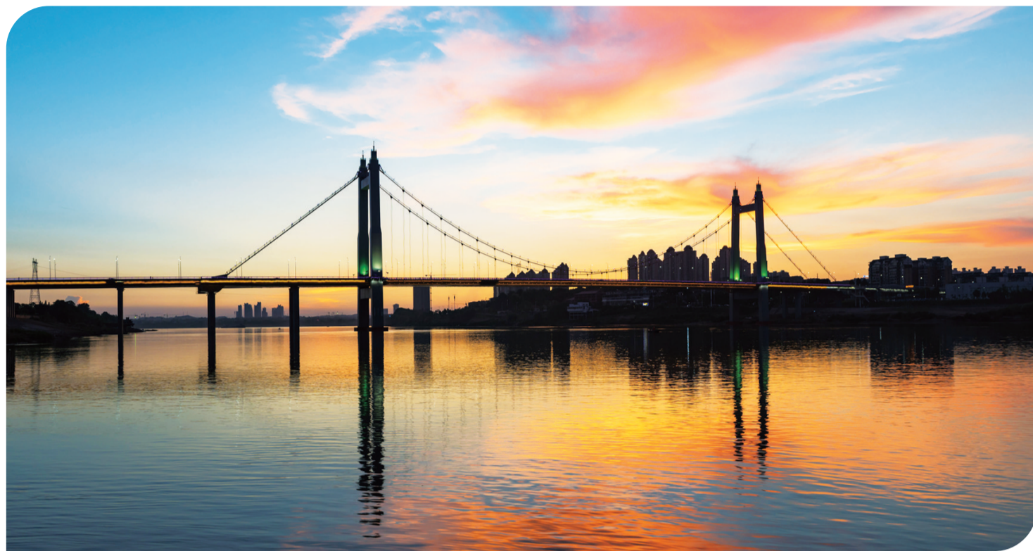
▲枫溪大桥夕照 刘小波/摄
