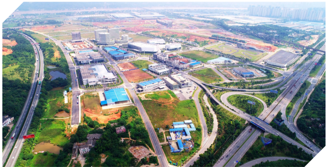
建设中的株洲汽博园
