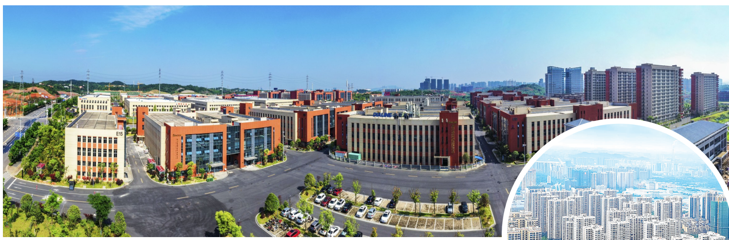
建设中的天易科技城
