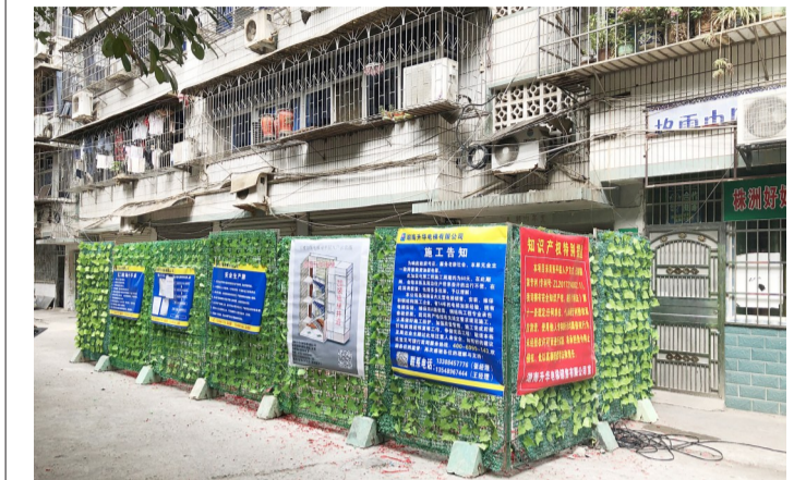
保利高尚小区已经开工的加装电梯 记者 周嵩 摄
