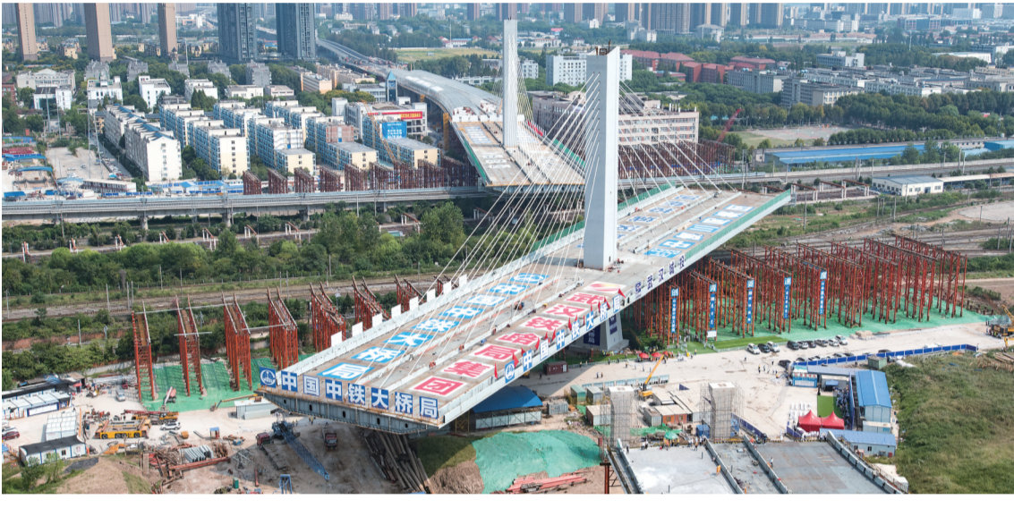
9月11日,武汉杨汨港快速通道青菱段跨铁路斜拉桥进行转体施工。当日,总重达3.6万吨的武汉杨汨港快速通道青菱段跨铁路斜拉桥顺利完成转体,成功跨越包括京广铁路在内的11条铁路线。这次转体的斜拉桥是一座双塔双索面钢箱梁斜拉桥,主塔高83.6米、桥长508米,桥梁设计为双向八车道。
