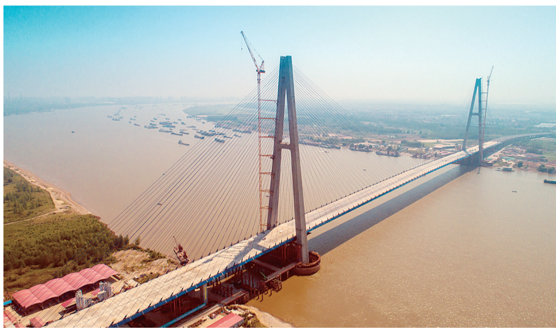
这是建设中的武汉青山长江大桥(9月9日无人机拍摄)。新华社记者 熊琦 摄
