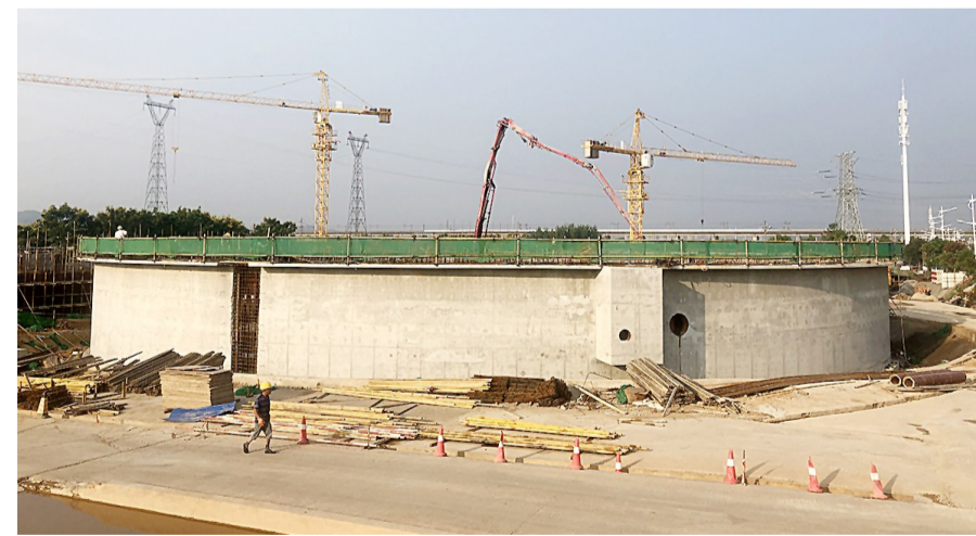
河西污水处理厂二期项目施工现场 记者 杨凌凌 摄
