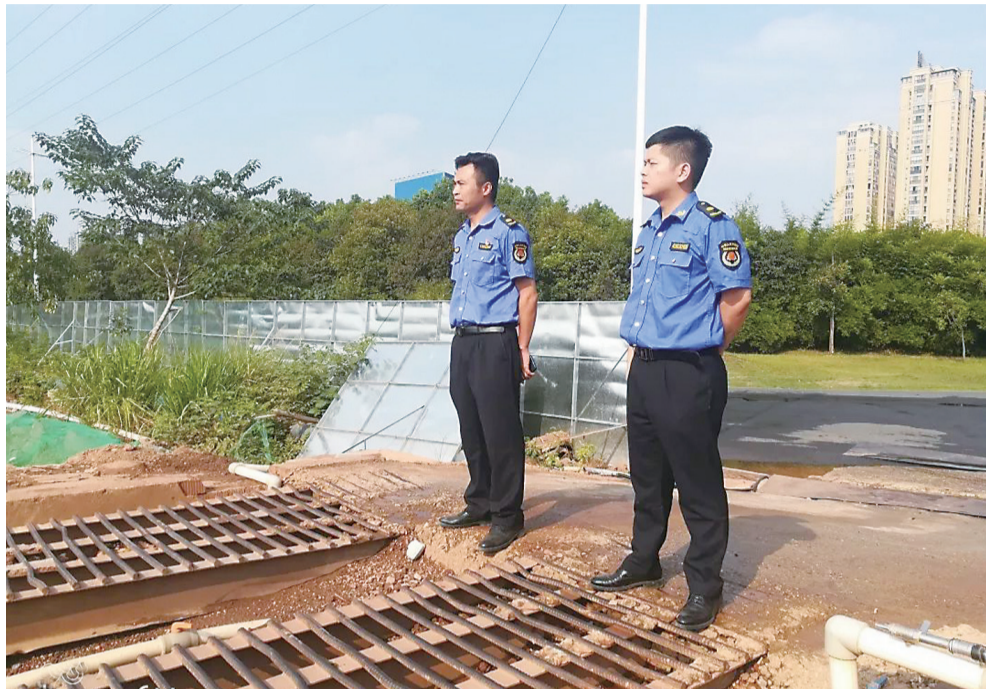
▲市城管支队组织开展工地扬尘防治交叉检查 通讯员供图
