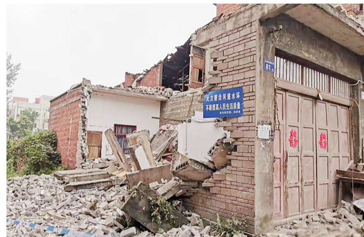
▲图为在地震中受损垮塌的民房
