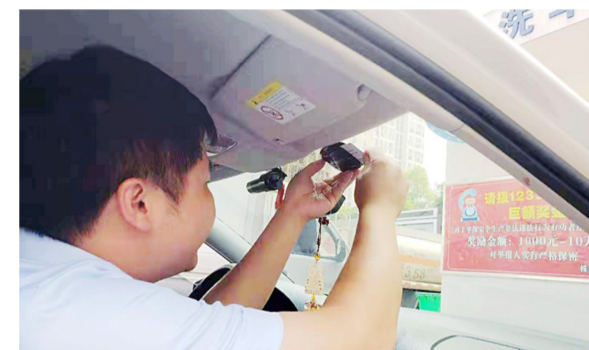
▲专业人员正在安装车载电子标签
