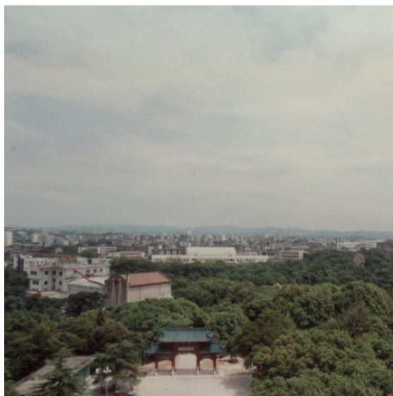
兴建中的河西。株洲档案馆 供图
