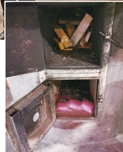
▲餐馆使用的柴火灶 通讯员供图
