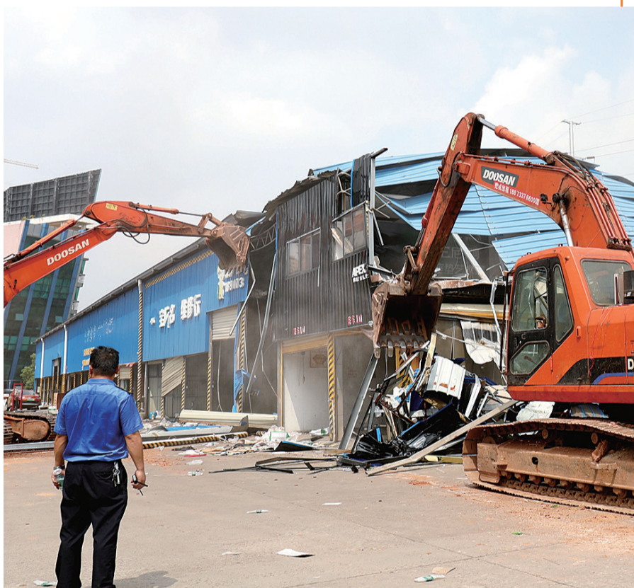
挖机拆除被清场腾房的违法建筑。沈全华 周子熙 摄
