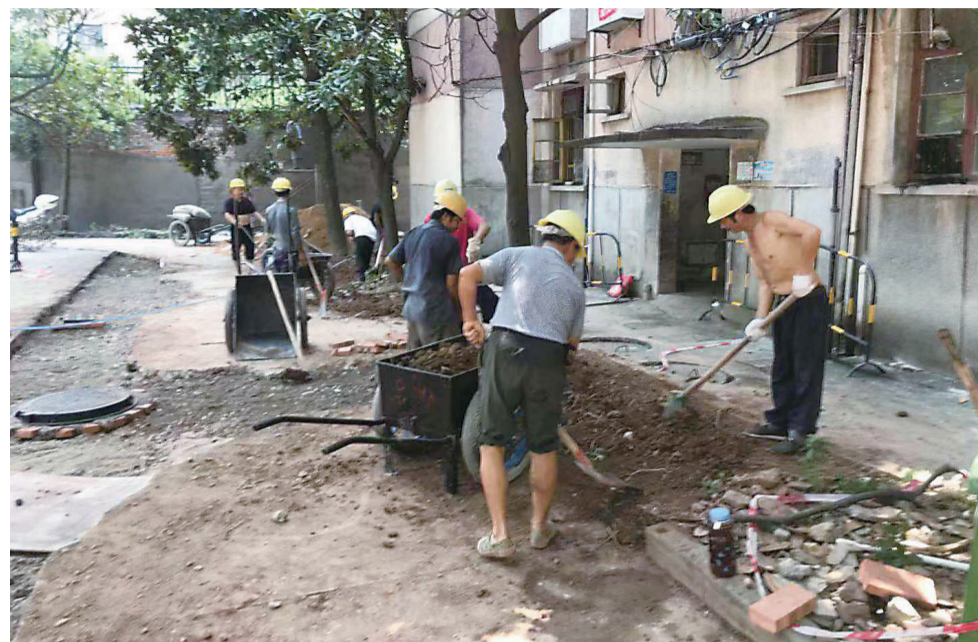
▲昨天下午,施工现场一片繁忙 通讯员供图
