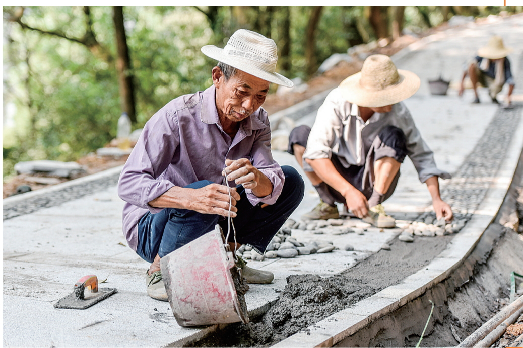
凤凰山公园项目现场，工人们正抓紧工期，铺设游园道路。株洲日报记者 刘震 摄
