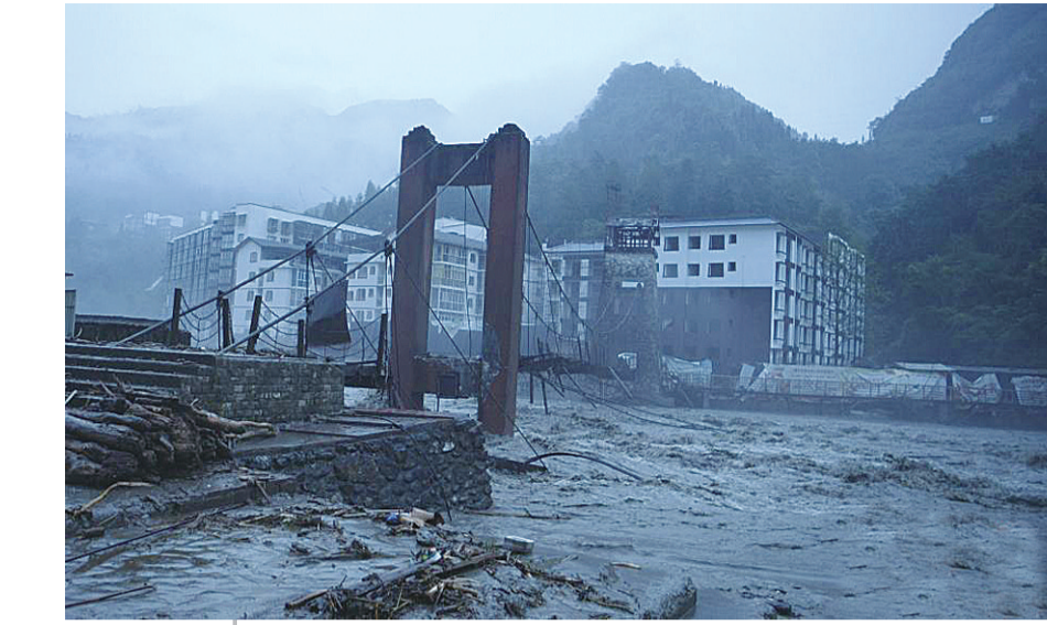
◀图为汶川三江镇被洪水冲毁的吊桥
