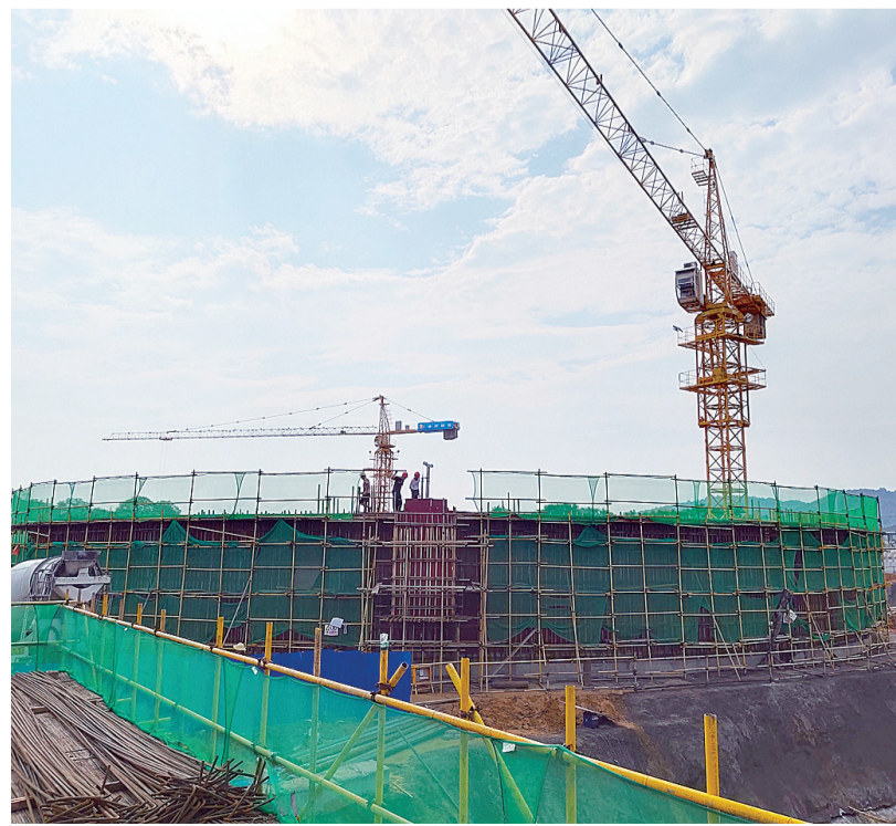
河西生活污水处理厂二期项目现场。廖明摄
