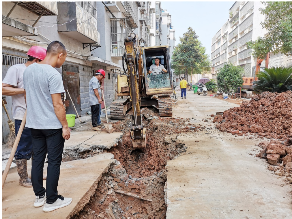
▲铁路小区正在进行“三供一业”改造 记者 姚时美 摄
