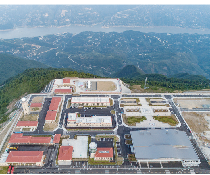
建于群山之巅的重庆巫山机场(7月15日无人机拍摄)。新华社发(重庆机场 供图)
