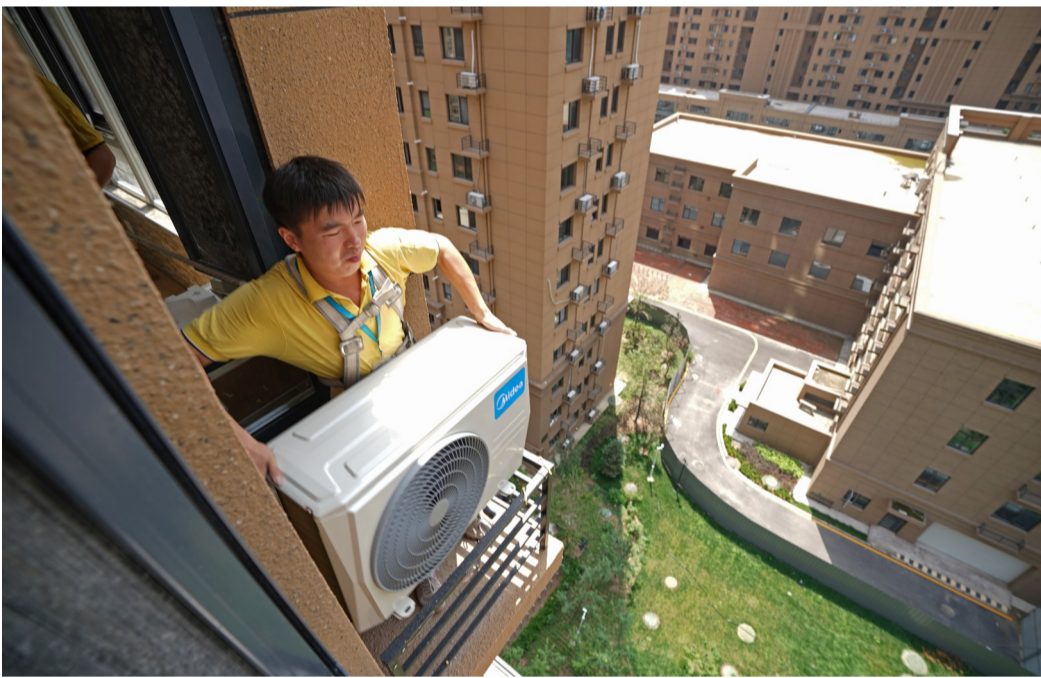
在北京朝阳区王四营地区的一个小区，空调安装工程师郑亚兵在11层楼的高空安装空调室外机。新华社发
