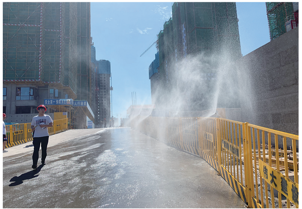
金轮·津桥华府项目的工地上,移动雾炮车360度旋转喷射、雾化水喷淋系统定时开启降低空气中粉尘。吴楚 摄
