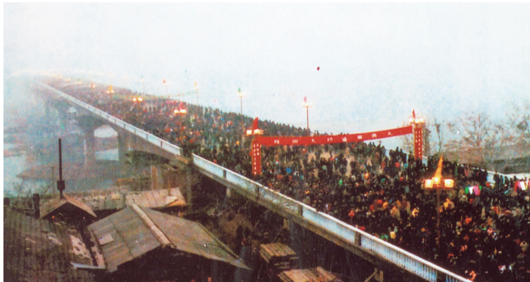
1988年12月28日，株洲大桥通车典礼举行当天，数万市民上桥，热闹非凡。 市档案馆 供图
