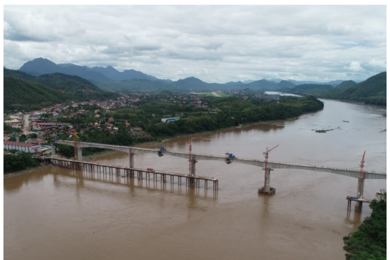
这是7月28日拍摄的合龙后的中老铁路老挝拉勃拉邦湄公河特大桥。 随着最后一个合龙节段混凝土的浇筑,中老铁路老挝拉勃拉邦湄公河特大桥28日成功合龙,实现全桥贯通,比计划工期提前7个月。 新华社发(中铁八局供图)
