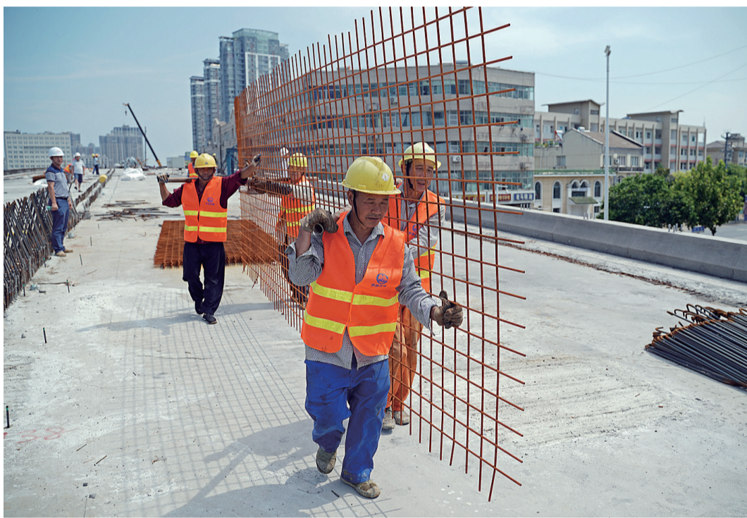
7月28日,工人在江苏省宿迁市泗洪县青阳南北大桥改造及城区部分路网提升工程工地上作业。 新华社记者 才扬 摄
