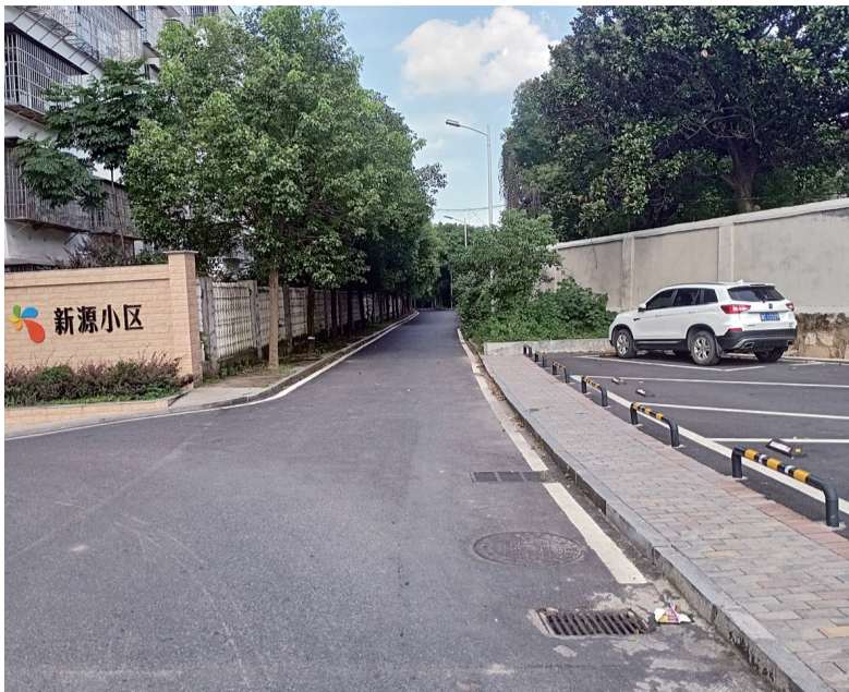
石峰区先锋安置小区入口的道路修缮一新。吴楚/摄
