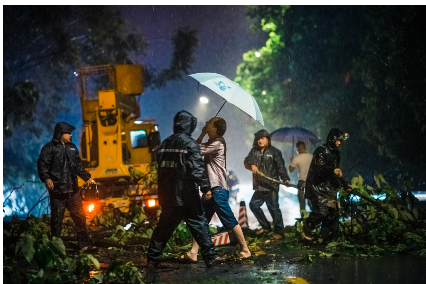
▲园林工作人员对路面倒塌树木进行清理
