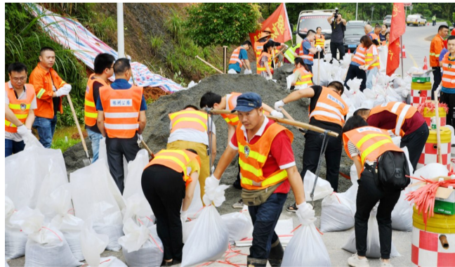
公路部门人员紧急抢修 通讯员供图
