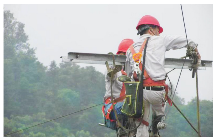
▲“爷爷军”在抢修电力设施 通讯员供图
