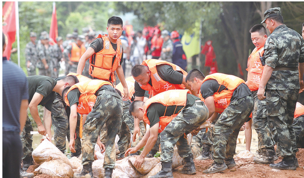
救援人员干堤现场抢险。朱刚摄
