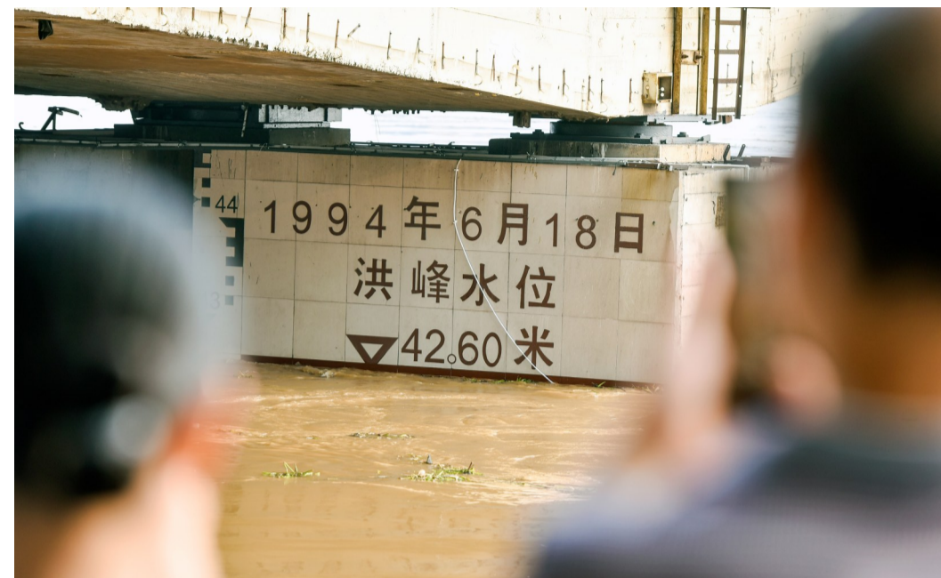
▲昨日下午5点30分,江水几乎与株洲大桥桥墩刻线齐平,42.60米为“85黄海高程”,换算成水文部门采用的“吴淞高程”为44.58米 记者 刘震 摄
