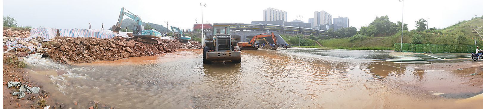
▲昨日下午,江淅路铁路涵洞附近,抢险人员加紧抢修保卫铁路运输安全 易浩山 摄
