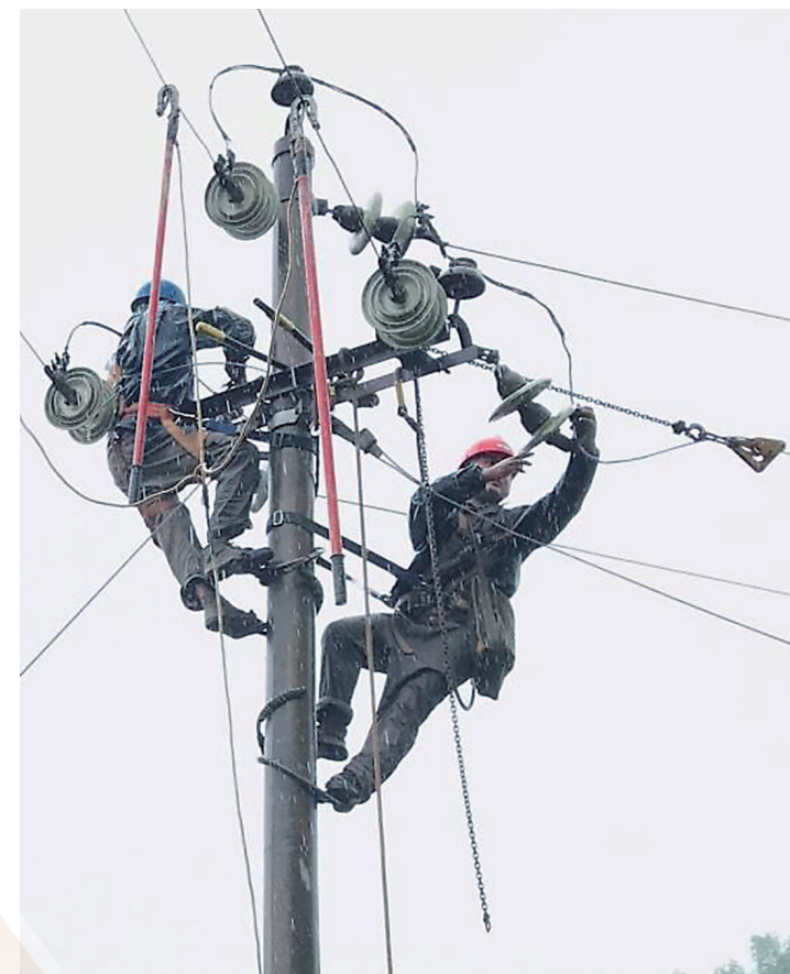
▲国网株洲供电公司冒雨抢修受损设施 通讯员 吴珊 供图
