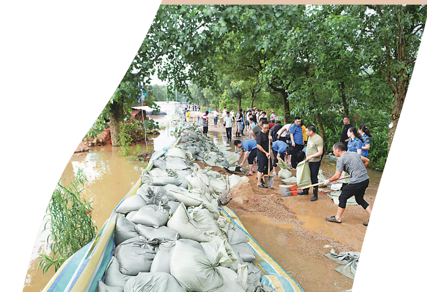
▲昨日,雷打石镇盘石村,干部群众正在用沙袋加固堤坝 记者 谢慧 摄
