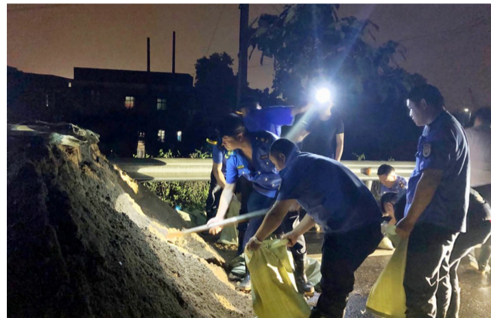
▲争分夺秒,抢险人员赶在洪峰过境之前对渗水的涵管进行封堵 江彭 摄
