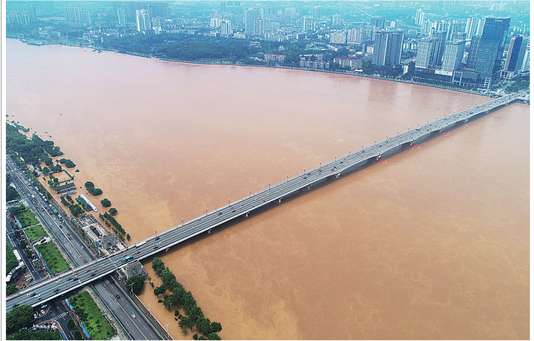
▲昨日,湘江洪峰过境,空中俯瞰株洲大桥 记者 谭浩瀚 摄
