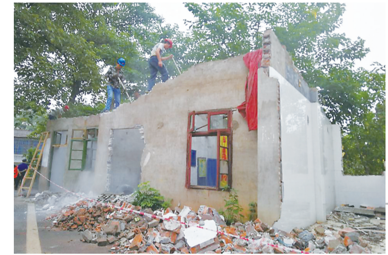
▲昨日上午,工作人员对违章建筑进行拆除 记者 李卉 摄
