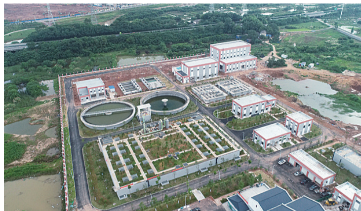
▲云龙污水处理厂一期竣工投用 记者 谭清云 摄
