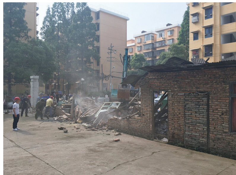
临时工棚被拆除。刘平 摄
