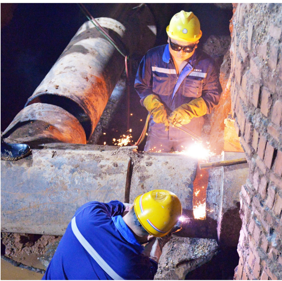
盛夏来临,居民用水进入高峰期。6月24日深夜,市水务集团抢修队组织200余名抢修队员,对二水厂沉淀池进行维护,并同步对6处供水主管网进行维修,以确保夏季高峰期供水安全。图为维修现场。 株洲日报记者 谭浩瀚 通讯员/张家诚 摄
