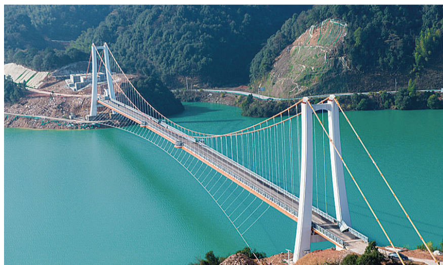
▲酒仙湖新建的水云桥跨湖而立,更方便游客赏景 主办方 供图
