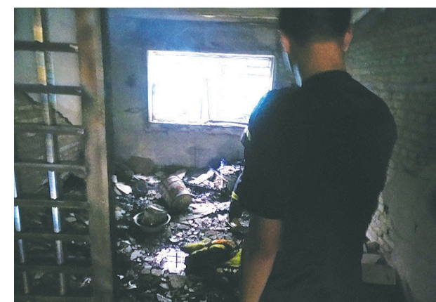
▲杂物间被烧得一片狼藉 消防部门供图
