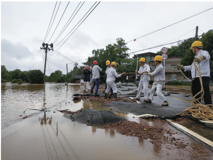
株洲供电公司员工正在进行抢修。李志强 摄
