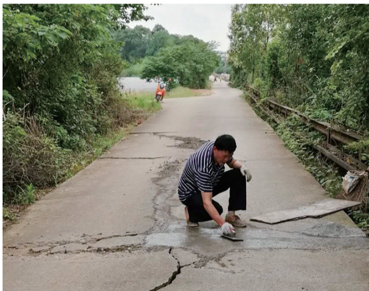
包加强在修补路面裂缝。栗栗村村委供图
